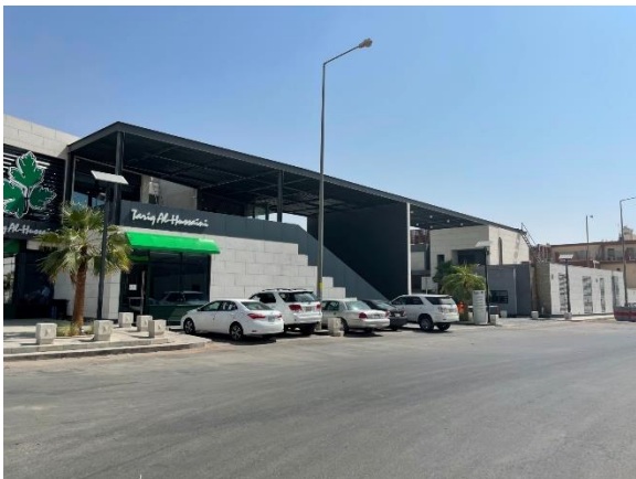
واجهة المبنى الشرقية
