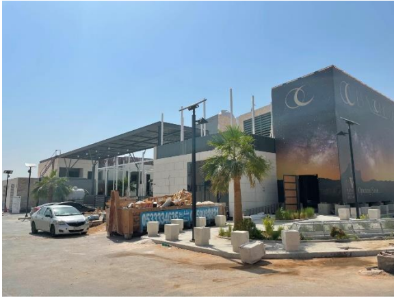
واجهة المبنى الشمالية
