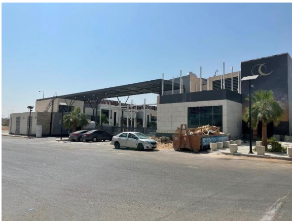
واجهة المبنى الغربية
