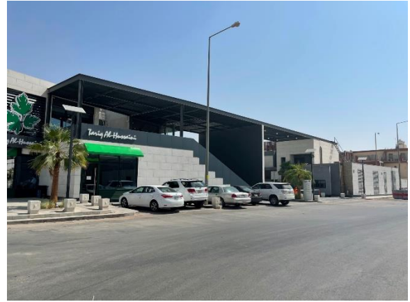
واجهة المبنى الشرقية
