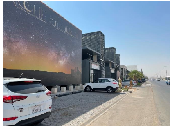
واجهة المبنى الشمالية
