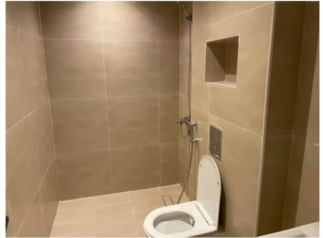
دورة مياه إحدى شقق الدور الأرضي - العمائر
